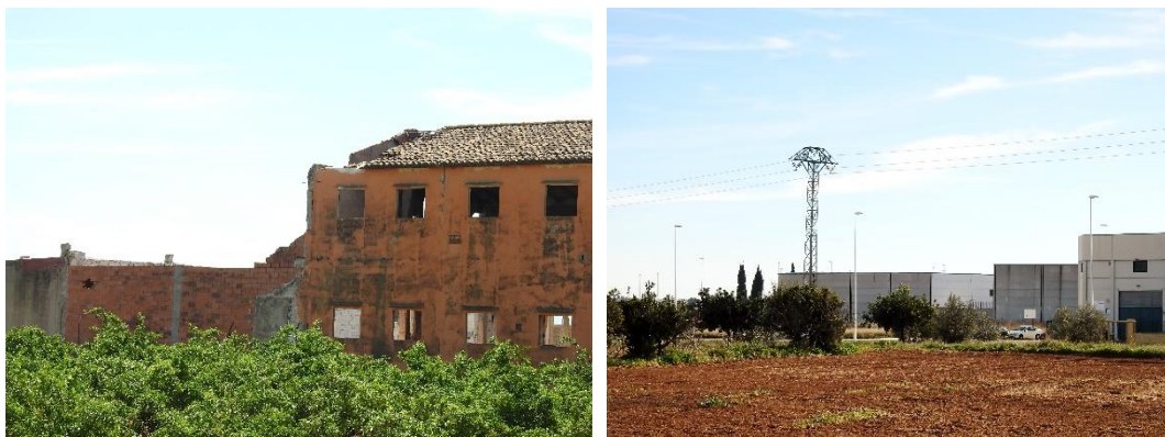
Figura 28. La intrusión visual de edificaciones abandonadas junto a diversas torres y tendidos eléctricos existentes en su entorno inmediato, disminuyen la calidad visual del paisaje.
