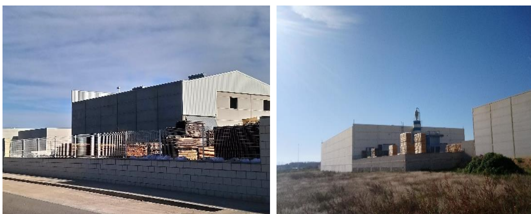
Figura 29. El almacenamiento de material en altura en las parcelas privadas sin protección visual percibido desde la calle empeora la calidad visual del paisaje.
