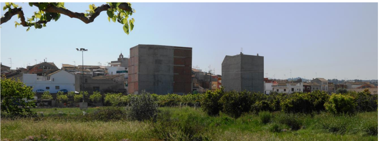
Vistas del perfil este de Catadau, con las traseras y medianeras vistas de dos grandes bloques, fuera de escala, pero adecuados al planeamiento vigente. Fuente: AUG-ARQUITECTOS SLP
