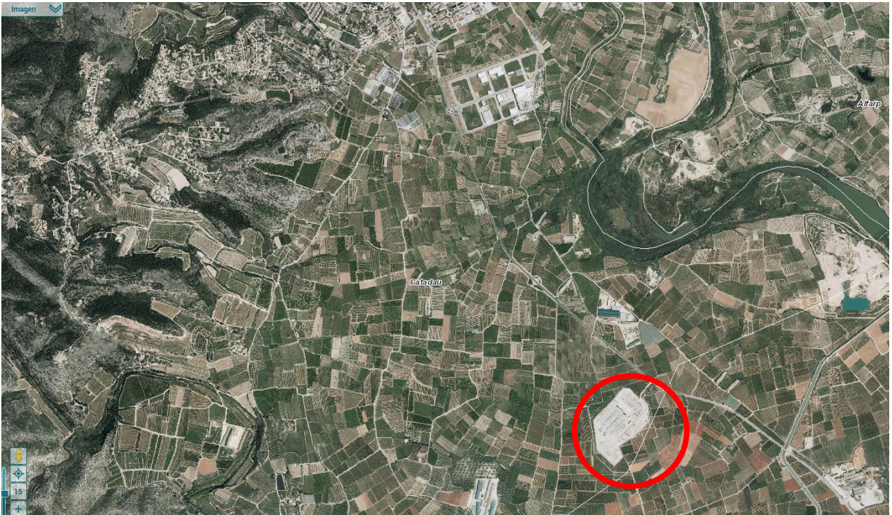
Ortofoto de Catadau en la que se observa, al sureste, la central eléctrica (en un círculo rojo). Fuente: https://visor.gva.es/visor
